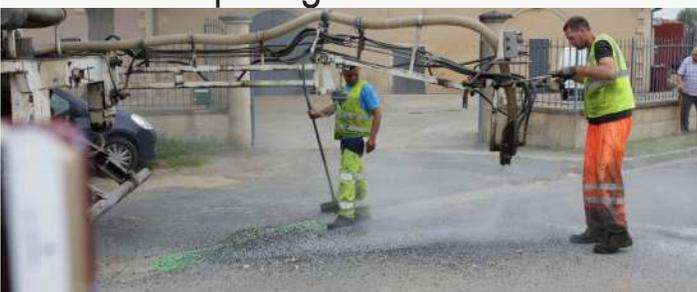
Fin juin un point à temps important a permis de combler un nombre important de nid de poules et de consolider la voirie fragilisée par les intempéries.
