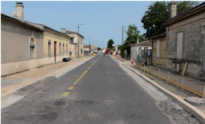
La chaussée réservée à la circulation des véhicules est réduite selon la réglementation afin de laisser la place suffisante à un cheminement doux et à une piste cyclable.
